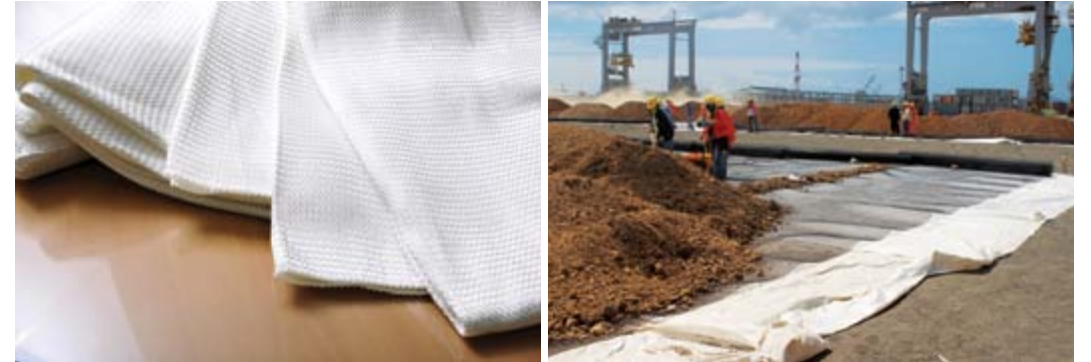
토목공사의 필수품인 토목섬유는 강도가 다른 연약지반을 균일하게 지탱해주는 역할을 하기 때문에 일반 섬유와 달리 수십 톤의 힘을 가해도 찢어지지 않는다.
